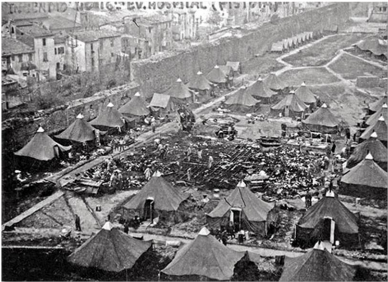
16º Evacuation Hospital após incêndio.
